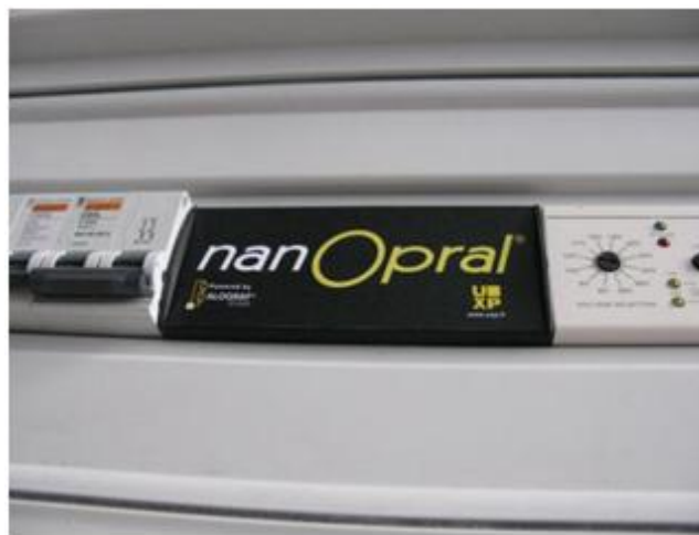
Exemple d'intégration dans un tableau électrique standard
