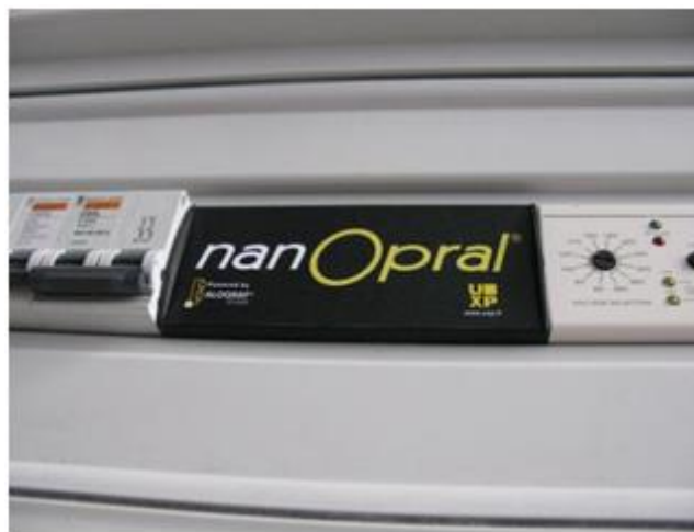
Exemple d'intégration dans un tableau électrique standard
